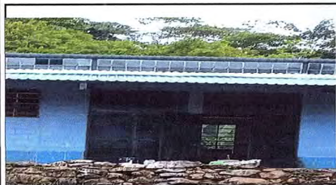
Foto 3: Aula 1: Mantenimiento de puerta
