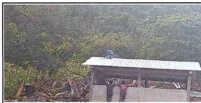
Foto 6: construccion de cocina
