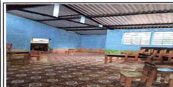
Foto 5: Aula 1. Cambio de pintura lado Interior Y exterior.
