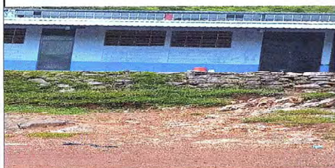
Foto1: Aula 1. Multigrado sustitucion de estrucctura de techo
