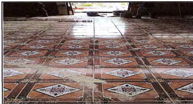
Foto 4: Aula 1 sustitucion de piso a ceramica
